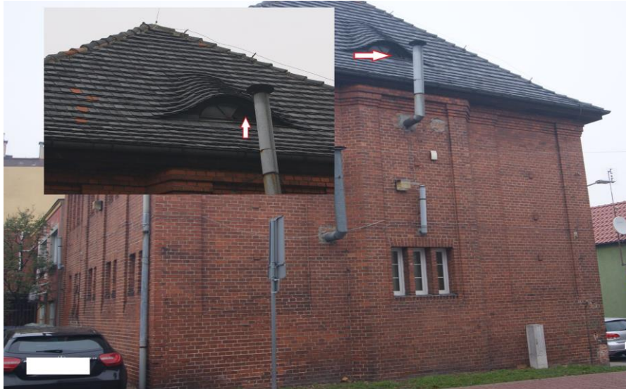
Fot. 1. Lukarna („wole oko”) z brakującą szybą na dachu (zaznaczona strzałkami) od strony południowej, umożliwiającą ptakom zasiedlenie strychu. Fot. J. Stępniewski.
